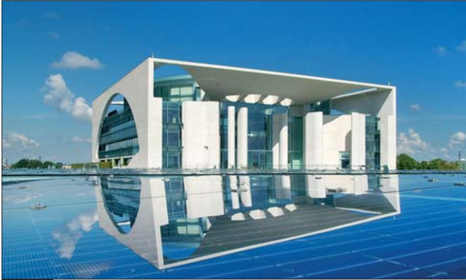
Abb. 9 Eine große Photovoltaikanlage in Berlin. Im Hintergrund das Bundeskanzleramt. (Bundesverband Solarwirtschaft)
