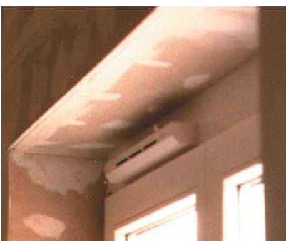
Feuchtgesteuerte Nachströmöffnung zum Einbau in den Fensterrahmen
